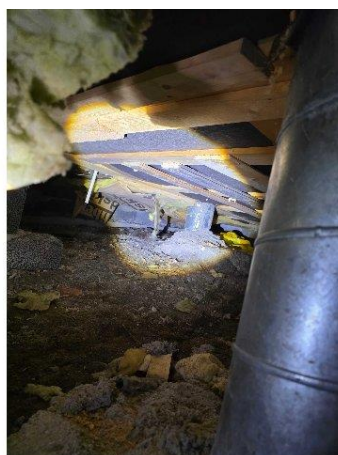
Bild 8: - Utvändigt, Grundmur/Hussockel, Krypgrund,.
