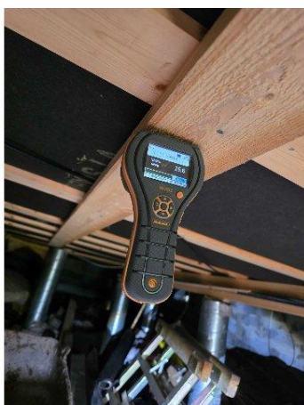
Bild 1: - Utvändigt, Grundmur/Hussockel, Krypgrund, se riskanalys.
