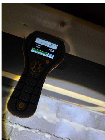
Bild 3: - Utvändigt, Grundmur/Hussockel, Krypgrund, se riskanalys.
