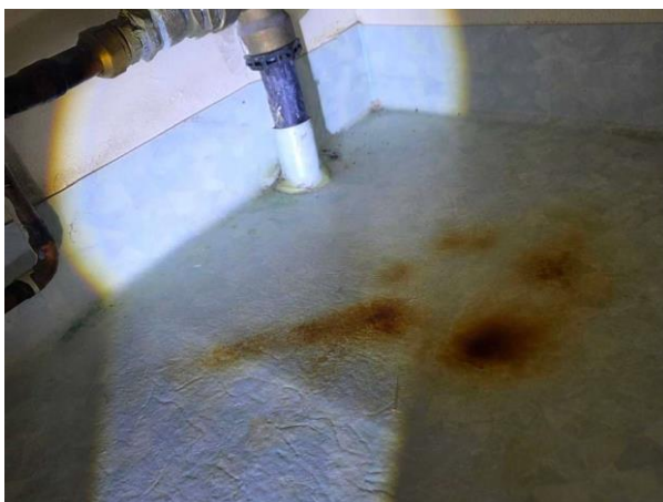
Bild 16: - Invändigt, Källarplan, Äldre tät och ytskickt. Öppna mattskarvar på golv. Fuktmärken på vägg vid ventil. Otäta rör genom...
