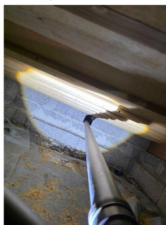
Bild 4: - Utvändigt, Grundmur/Hussockel, Krypgrund, se riskanalys Fuktmärken på trossbotten vänster om inspektionslucka. Markplats saknas ...
