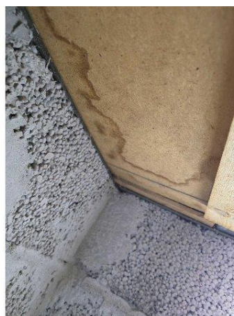
Bild 2: - Utvändigt, Grundmur/Hussockel, Krypgrund, se riskanalys Fuktmärken på trossbotten vänster om inspektionslucka. Markplats saknas ...
