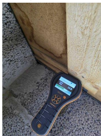
Bild 6: - Utvändigt, Grundmur/Hussockel, Krypgrund, se riskanalys Fuktmärken på trossbotten vänster om inspektionslucka. Markplats saknas ...
