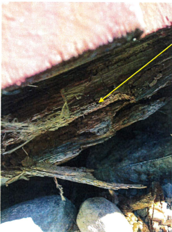
Rötskadad bottenstock.
