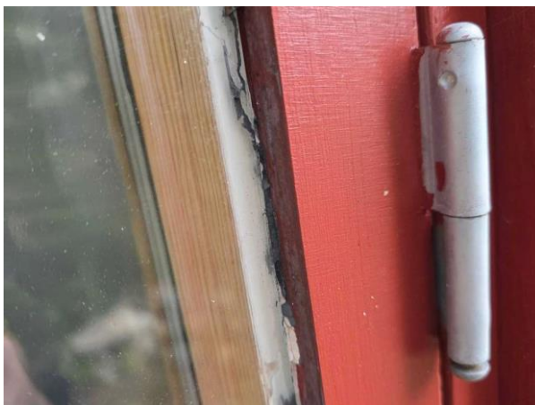
Bild 4: Utvändigt, Fönster, Kittskador noterades på fönster
