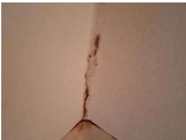
Bild 15: - Badrum Öppna mattskarvar på vägg.
