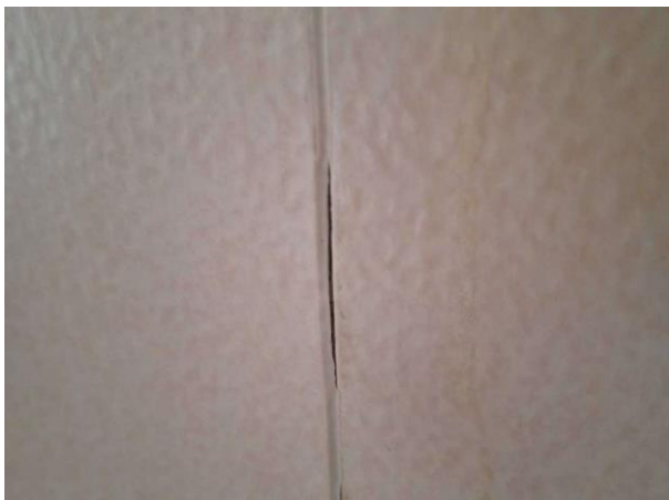
Bild 13: - Badrum Öppna mattskarvar på vägg.
