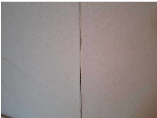
Bild 14: - Badrum Öppna mattskarvar på vägg.
