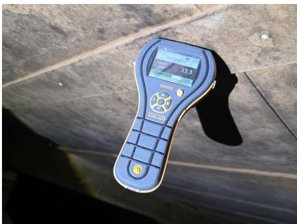
Bild 2: - Utvändigt, Grundmur/Hussockel. Påväxt på trossbottenskivor.
