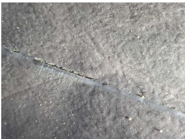
Bild 17: - Öppna mattskarvar.. Inga förhöjda fuktvärden uppmättes vid besiktningstil...
