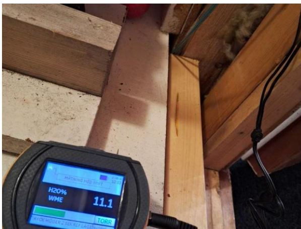
Bild 16: - Invändigt, Entréplan, Lukt Inga förhöjda fuktvärden uppmättes vid besiktningstillfället.
