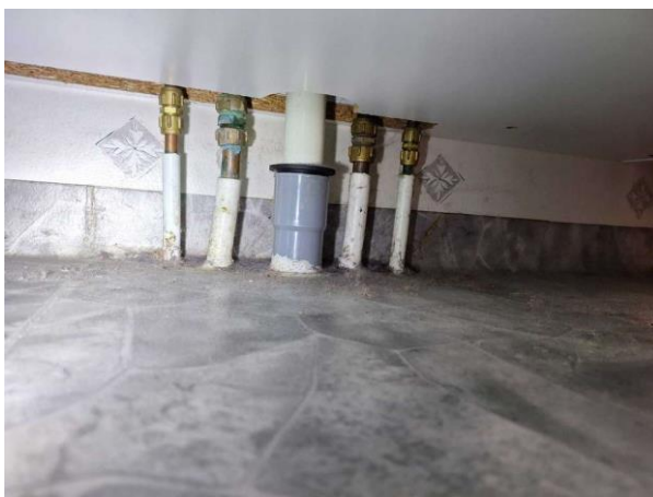
Bild 18: . Rör genomföringar i golv. Inga förhöjda fuktvärden uppmättes vid besiktningstil...
